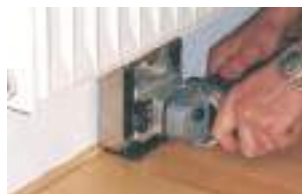
Tagliare giunto di dilatazione sotto elemento riscaldante
