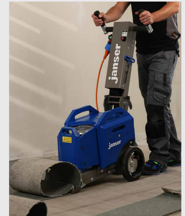
Ablösen von textilem Bodenbelag mit selbstschneidender U-Klinge
