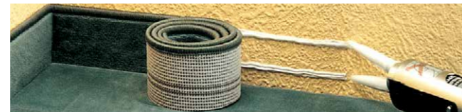
Teppichsockel: Auftragen von 2 Kleberlinien mit Alu-Doppeldüse und andrücken.
