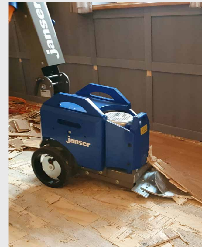
Einsatz der Parkettklinge Dynamische Form zur Entfernung von allen Arten von Parkettböden geeignet. Massiv-Parkett, Zwei- und Mehrschichtparkett
