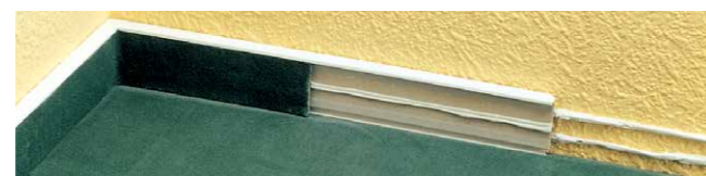
Einschubleisten: Auftragen von 2 Kleberlinien mit Alu-Doppeldüse, Fixieren und andrücken der Einschubleiste, Auftragen einer Kleberlinie in der Einschubleiste, Einbetten und anreiben des Teppichsockels
