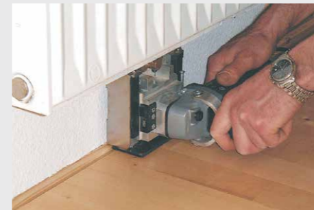
Dehnfugen schneiden unter Heizkörper
